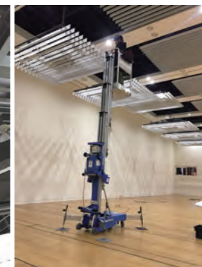
ギャラリー A のスピーカー取り付けは高所作業でした
