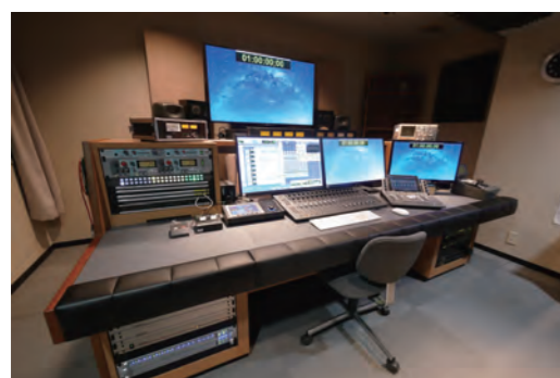
コンソール台は天板のみの張り替えで AVID S3 と PT Dock を設置しました
