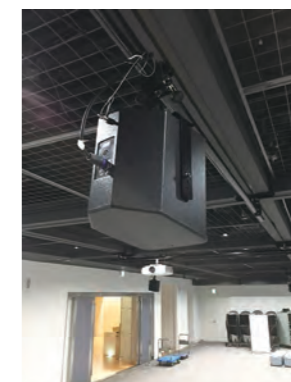
ギャラリー D のスピーカーは特型のボタンに取り付けました
