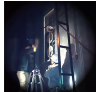
(写真3) スピーカーの取り外し
