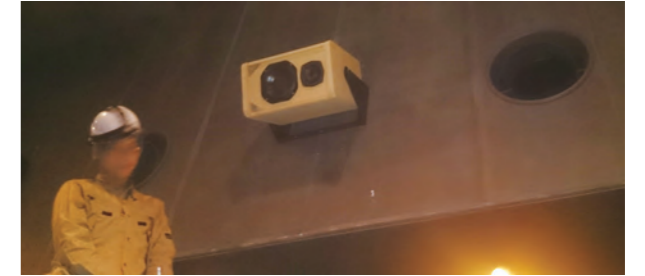
(写真8) 試作機の取り付け確認
