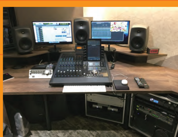
コントロールルームにコンパクトに設置した S6-M10
